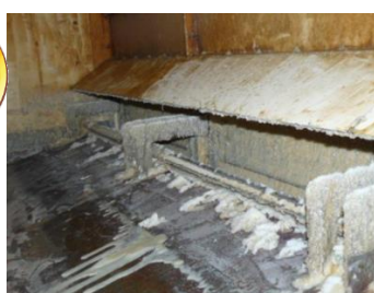
塗装ブース清掃工事
