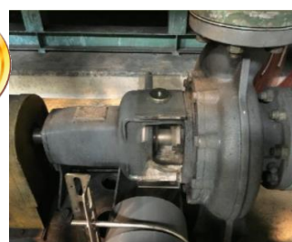
循環ポンプパッキン交換
